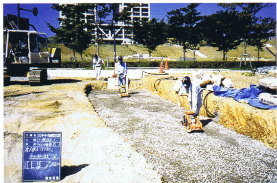
(ストラクチャル・ソイル・ミックスの転圧状況)
